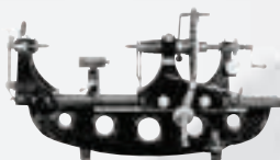
Измерительная машина, 1908 год. Отсчет по нониусу 1/10000 мм
